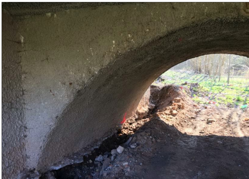
Foto 2: Naznačení polohy vrtu pod krajní opěru směr Broumov
