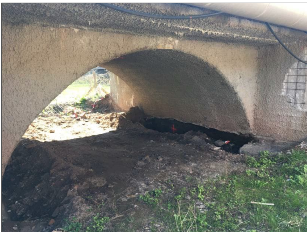
Foto 4: Naznačení polohy vrtu pod opěru směr Microzów
