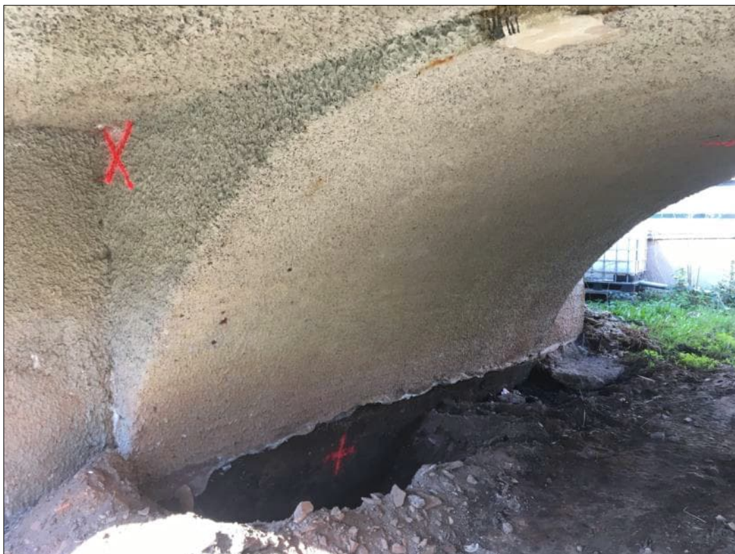
Foto 5: Naznačení polohy vrtu pod opěru směr Mierozów a poprsní zídky
